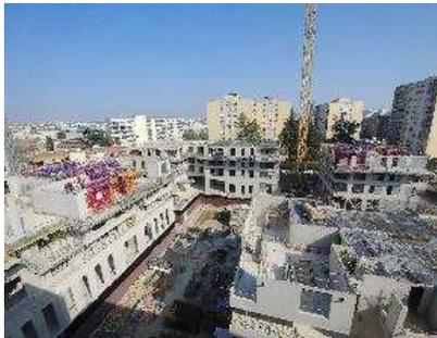
Les équipes Mazaud et Lafarge multiplient les prouesses pour ce chantier de 7 bâtiments et 161 logements. Les 11 000 m<sup>3</sup> de béton bas carbone ECOPact, contenant 30% de granulats recyclés permettent une réduction de l'empreinte carbone de plus de 50% par rapport à un béton traditionnel.
